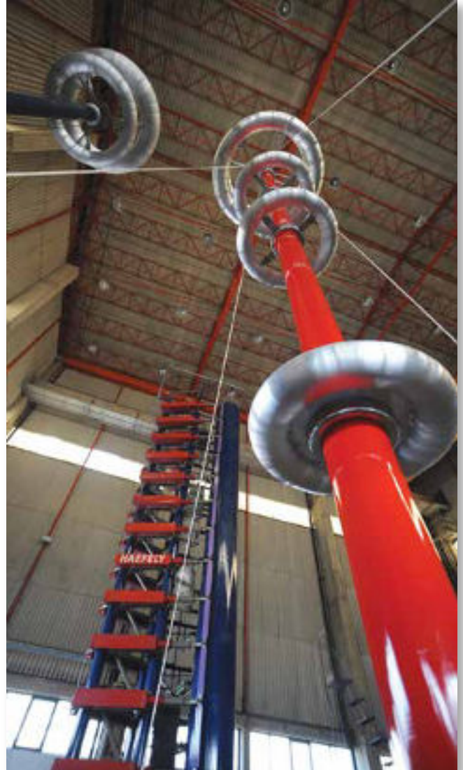
Yıldırım darbe jeneratörü gerilim bölücü.
